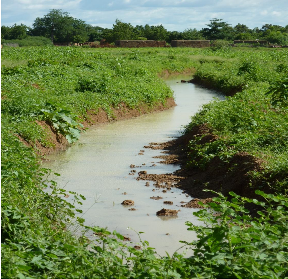
Aménagement de bassins versants : tranchée de collecte des eaux de pluie (Ouan C.Tominian)
