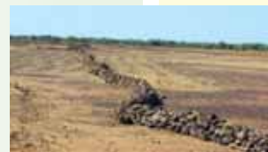
Dispositif du contour trenching: combinaison diguettes et tranchées/ Trenching contouring device: combination bunds and trenches
